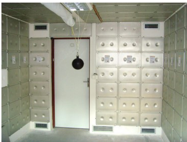
Obr. 15: Instalace obkladu z kazet s látkou pro akumulaci tepla při změně skupenství Zdroj: stavba.tzb-info.cz [18]
