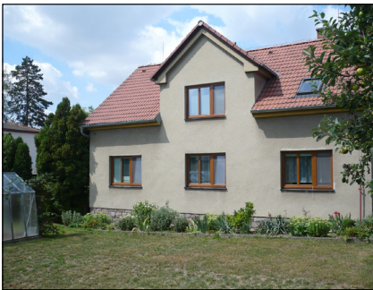
Foto objektu Zdroj: fotodokumentace autora
