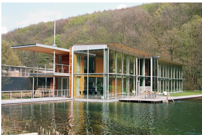
Obr. 19: Příklad realizace pasivní solární architektury – Kanceláře a dílny společnosti Biotop, Weidling, 2005
