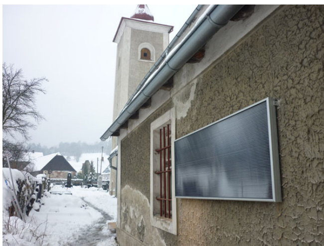
Obr. 9: Vzduchový kolektor na fasádě Zdroj: www.solarventi.cz [11]
