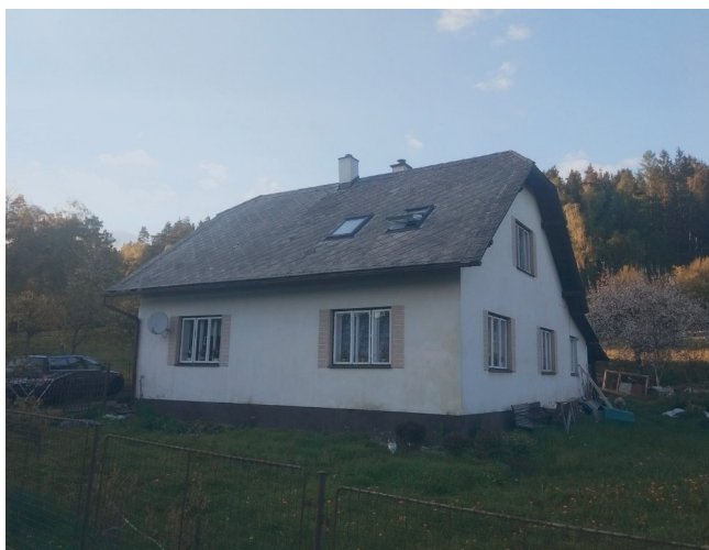
Fotografie řešeného objektu
