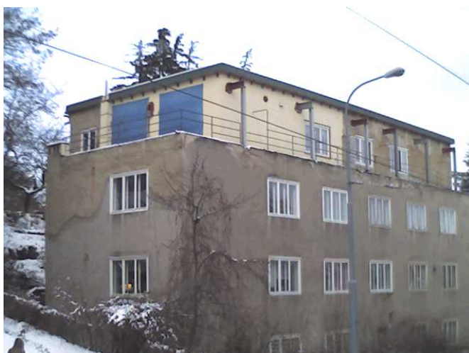
Obr.č.1 stávající fasáda objektu [1]
