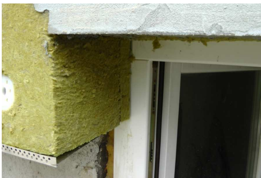
Obr.č.6 Nekvalitně provedená montáž tepelné izolace, klempířských prvků [1]
