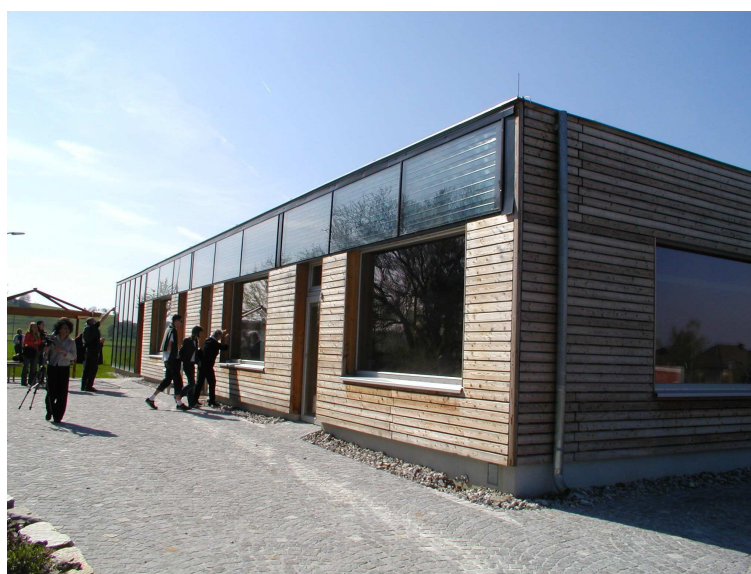
Obr. 3 Využití pasivní fasád pro energetický zisk – Rakousko 2012 [2]
