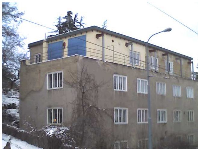
Obr.č.2 stávající fasáda objektu [3]
