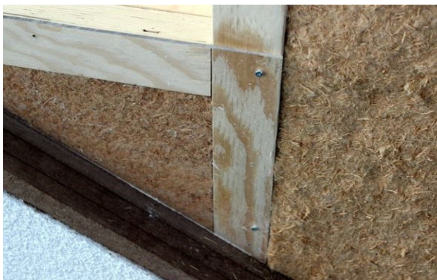
Obr. 3: Dřevovláknitá izolace ve sloupkové konstrukci dřevostavby
