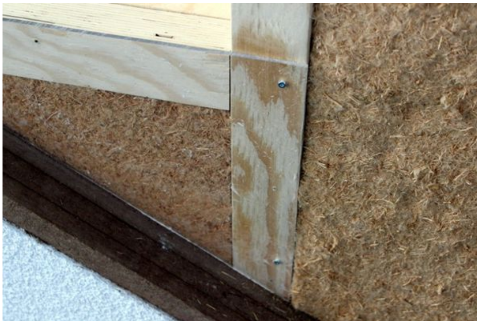
Obr. 7: Dřevovláknitá izolace ve sloupkové konstrukci dřevostavby
