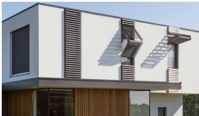
Obr. 10: Fasáda s využitím dřevěných slunolamů
